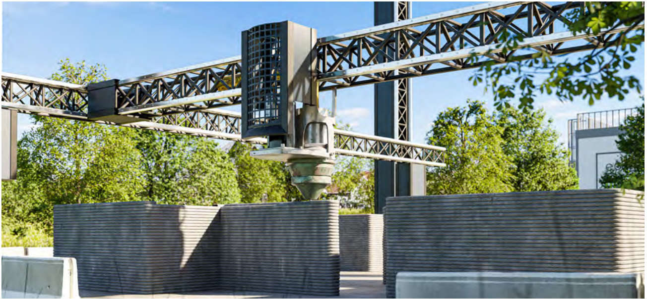
Un bâtiment construit en béton à l'aide de l'impression 3D.
